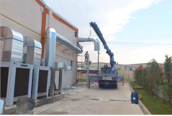
Evaporatif klima montaj aşaması
